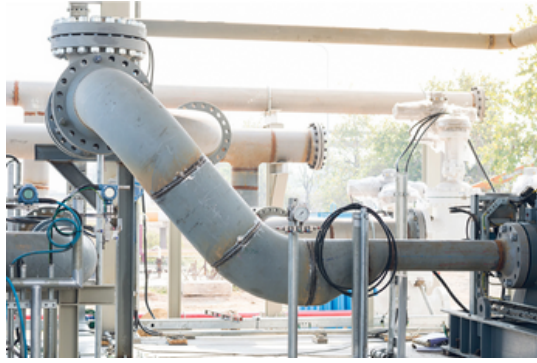
Şekil 9.12: Flanş ile Birleştirilmiş Boru Montajı
