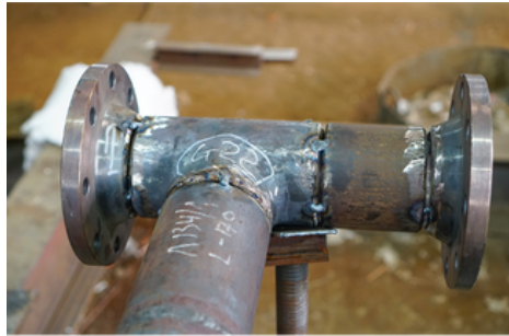
Şekil 9.13: Flanşın Tack Kaynağı
