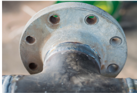
Şekil 9.14: Flanşın Dıştan Kaynağı
