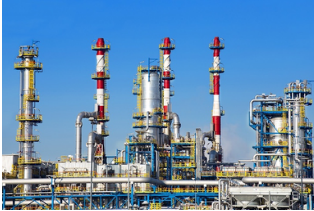
Şekil 9.2: Boruların Uygulama Alanlarından Biri
