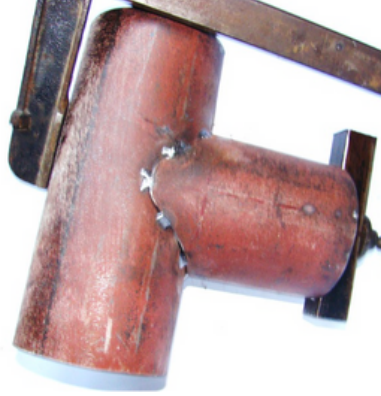
Şekil 9.19: Kesilmiş ve Montajı Yapılmış Kesişimlere Sahip Boruların Tack Kaynağı
