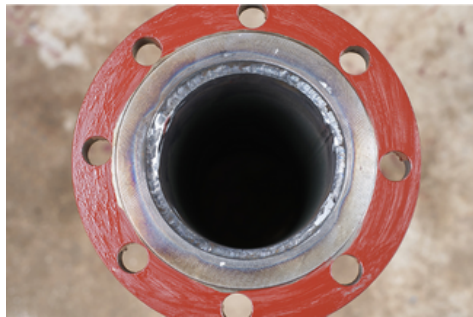
Şekil 9.15: Flanşın Tack Kaynağı
