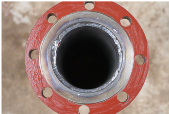
Şekil 9.15: Flanşın Tack Kaynağı
