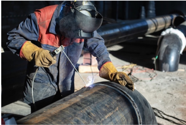
Şekil 5.3: Bazik Elektrotla Kaynak Uygulaması
