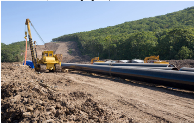
Şekil 9.3: Petrol Boru Hattı Kurulumu
