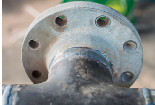
Şekil 9.14: Flanşın Dıştan Kaynağı
