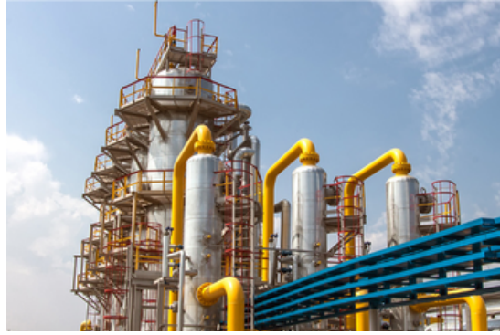
Şekil 9.1: Büyük Çaplı Boruların Sanayide Kullanımı
