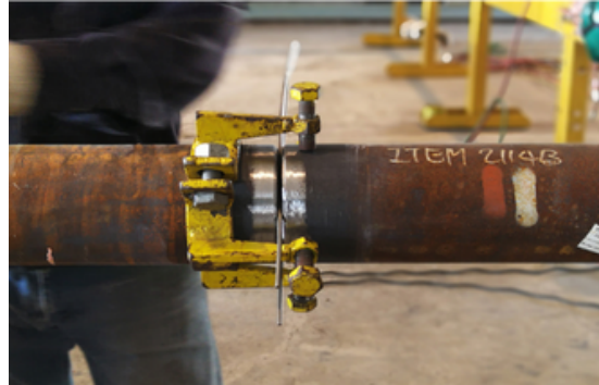
Şekil 9.9: Boru Uç Hazırlığı İçin Kullanılan Aparatlar
