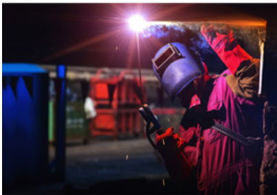
Şekil 4.11: Baş Üstü V Kaynağı Uygulamaları
